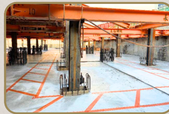
工區劃設安全通道
