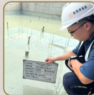
防水工程蓄水測試
