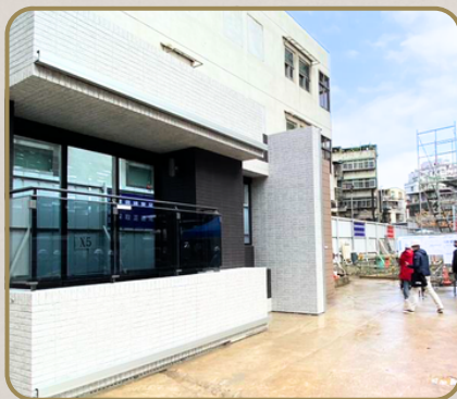
外牆實體樣板建置
