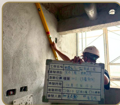
外牆粉刷平整度查驗
