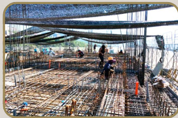
架設遮陽防曬設備
